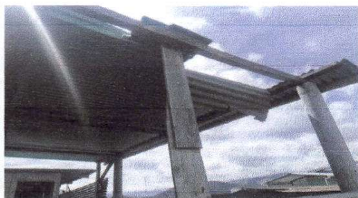
Foto 1: Sustrucción de lamina por lamina troquelada calibre 26
