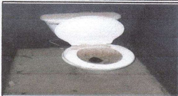
Foto1: Sustitucion de inodoros
